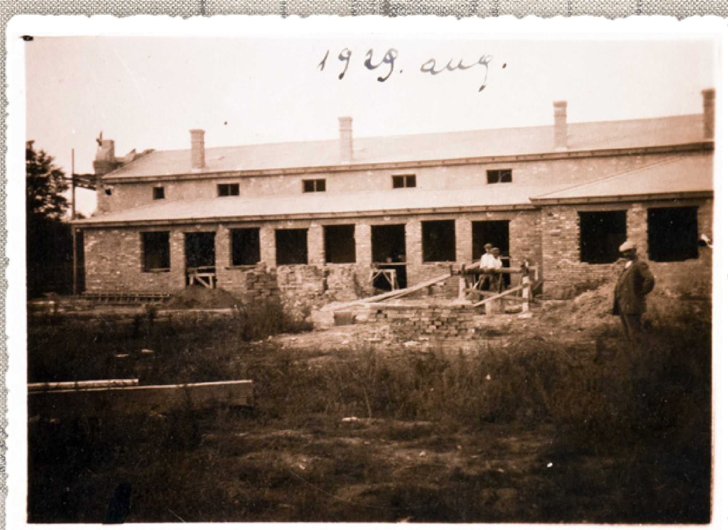
Kultúrház építés közben és elkészültekor
